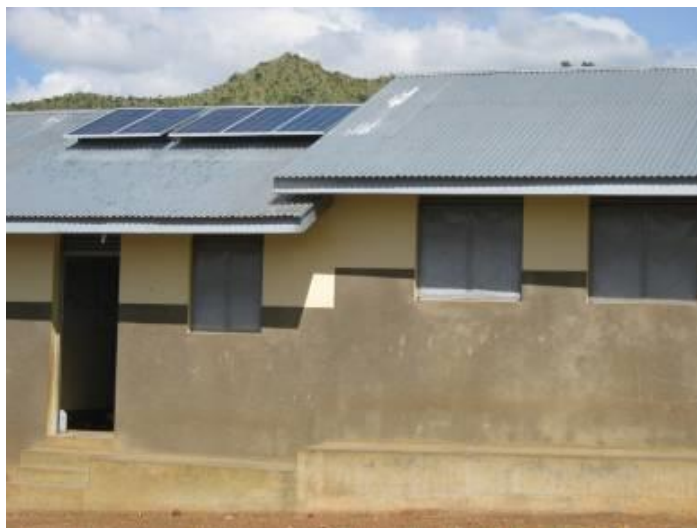
I pannelli a Musupo, sul tetto dell'ufficio del direttore.
